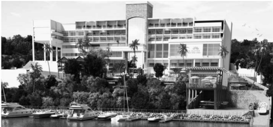
Figura 3: Projeto do Resort Termas Marina Itá, que está em construção
